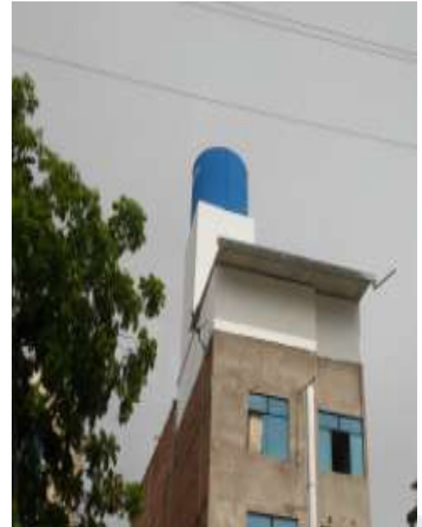
EBC_CAJ-002 ROOFTOP CAJAMARCA-MESONES MURO
