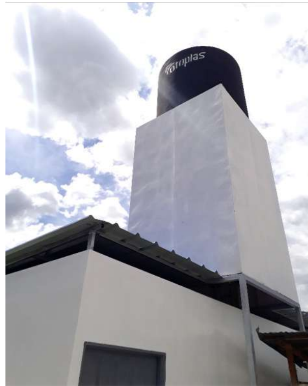
EBC_CAJ-001 ROOFTOP IQUITOS-MARISCAL CASTILLA
