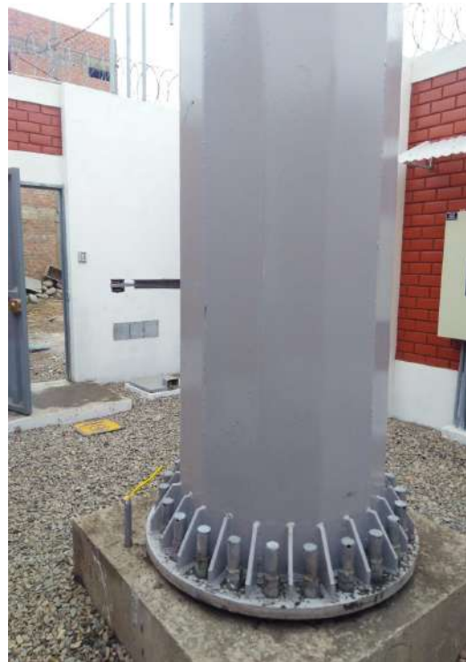
EBC_LIM-137 GREENFIELD LIMA-BARRIO REPARTIDOR
